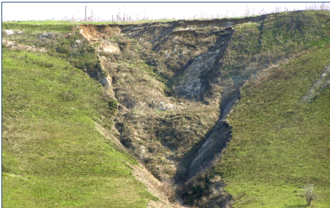
Рис. 2. Каплевидная форма оползня в вершине овражно-балочной системы
