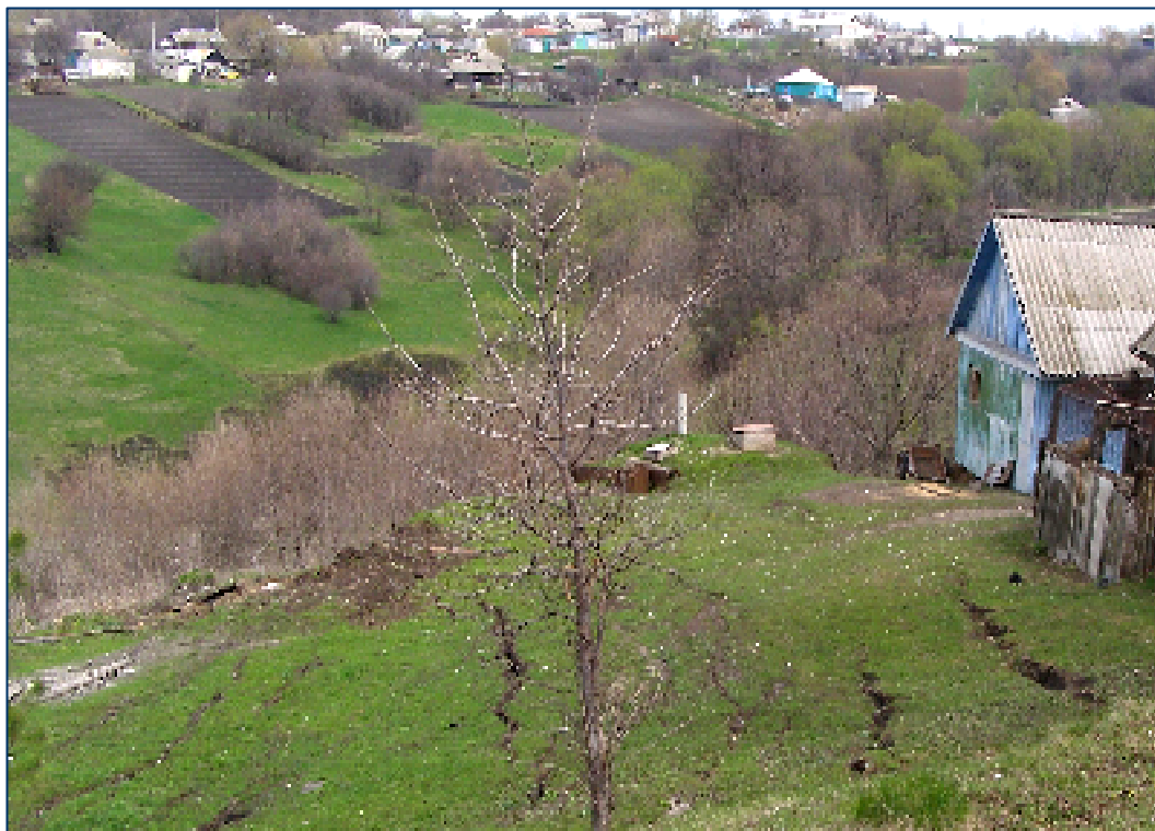
Рис. 6. Разрушение жилых построек оползнем в с. Щербаково Алексеевского района
